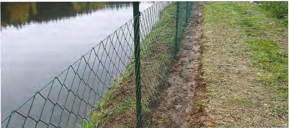
Abbildung 2: Der ca. 25 cm nach außen umgeknickte Maschendrahtzaun in der vorgebaggerten Künette (© Günther Gratzl)
