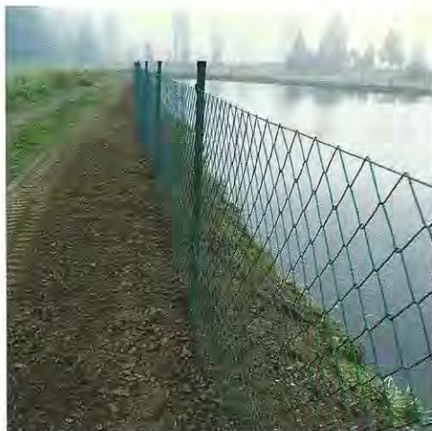
Abbildung 3: Detailansicht der fertigen Einschotterung mittels Vorabsiebmaterial 0/32 aus gebrochenem Schotter (Grädermaterial). Dieses Material lässt sich gut verdichten und bildet mit dem nach außen umgeknickten und eingeschütteten Zaun eine sichere Barriere gegen das Eindringen (© Grünther Gratzl)
